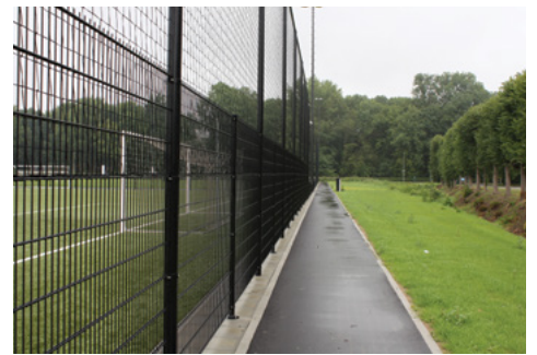
MOOSDORF Heras boldhegn. Støjsvag konstruktion med stålmattehegn i bunden og net i toppen.
